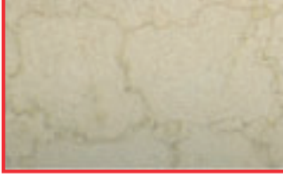
Buhar kondensatından kirlenmelerden dolayı oluşan leke deseni
